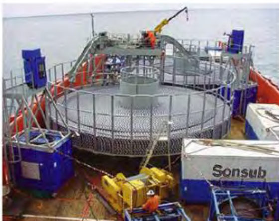
Abbildung 11-14: Die Verlegung des VSC-HGÜ VPE-Land-Kabels
