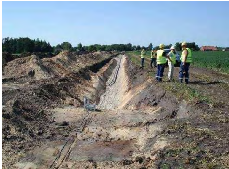
Abbildung 10-10: Verlegung eines VPE-HGÜ-Kabels
