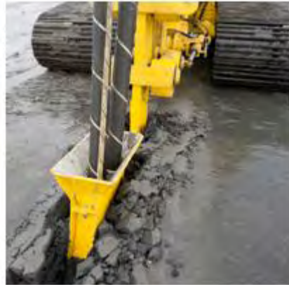
Abbildung 11-15: Offshore Plattform und die Verlegung des VSC-HGÜ VPE-Seekabels in Wattenmeer
