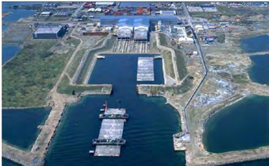
Abbildung 11-29: Herstellung von Tunnelsegmenten im Trockendock
